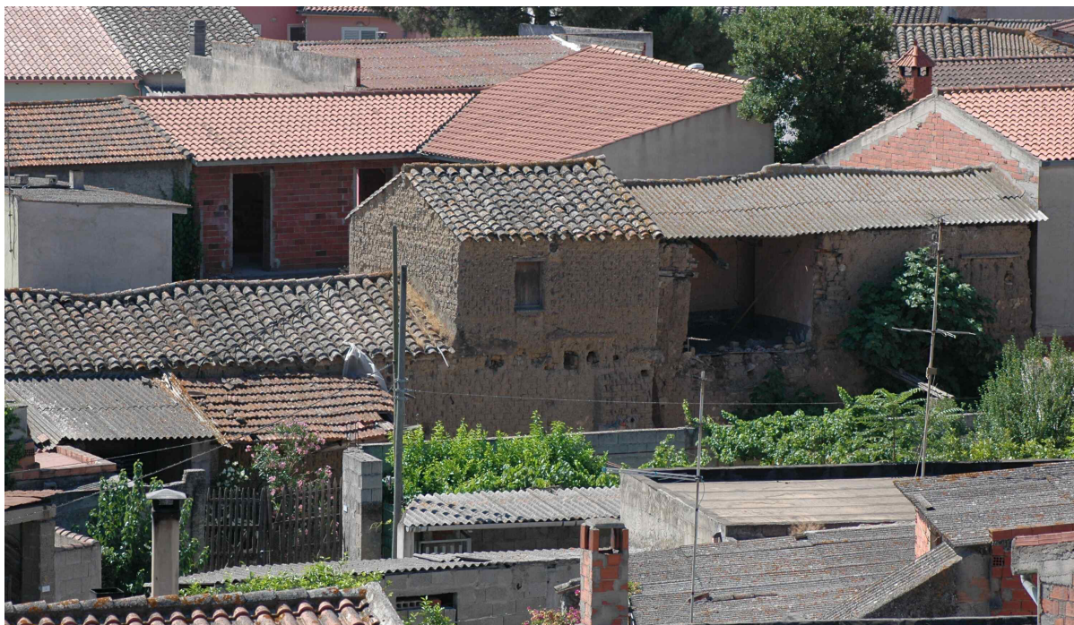
Fig. 11. Scorcio del Centro Storico.
