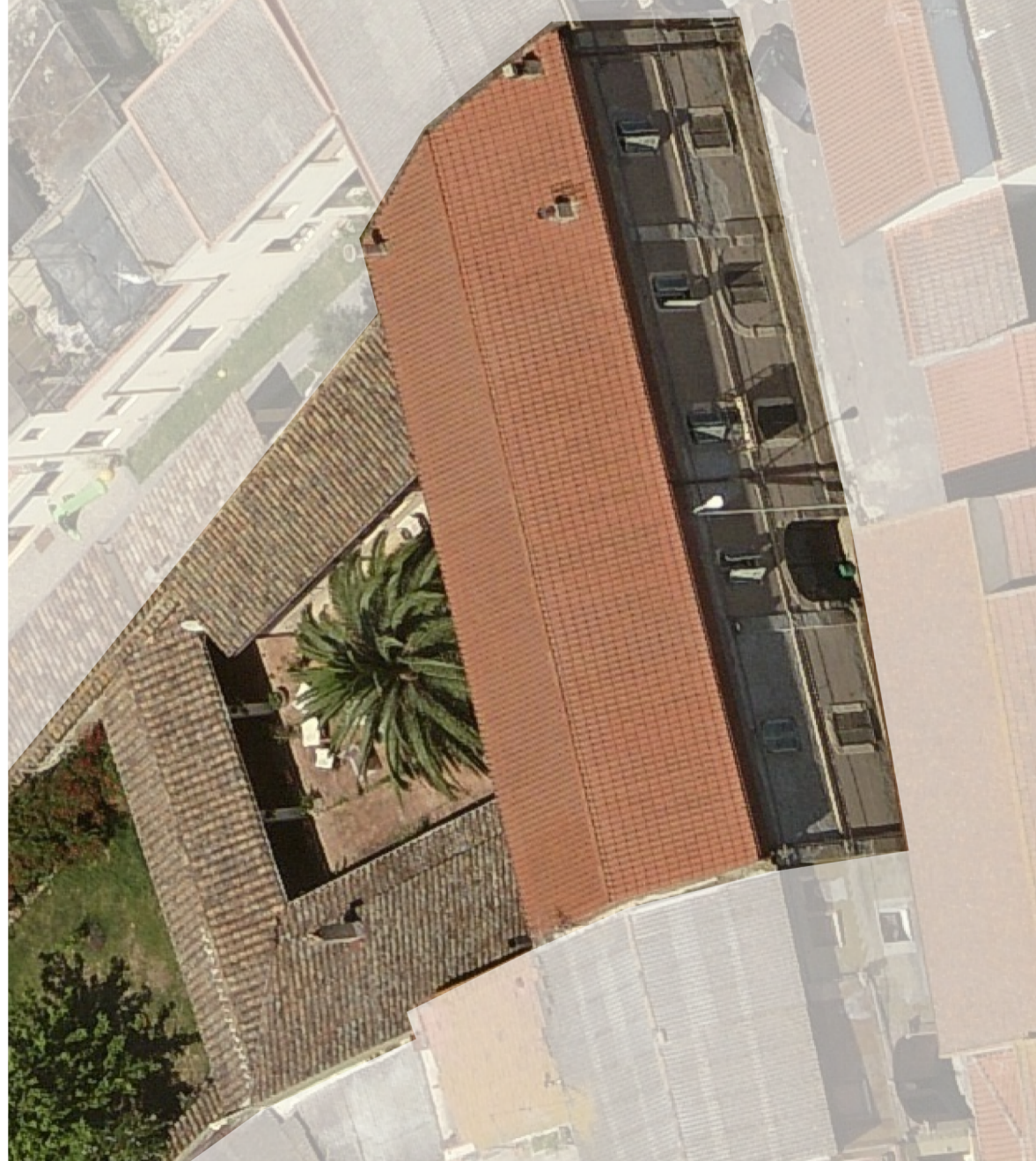
Foto obliqua stato attuale
