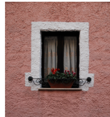
2.a | Infisso in legno a due ante, nessuna schermatura
