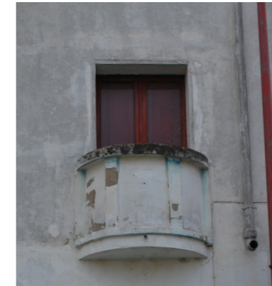
2.b.3.2 | Balcone aggettante con parapetto e impalcato in cls
