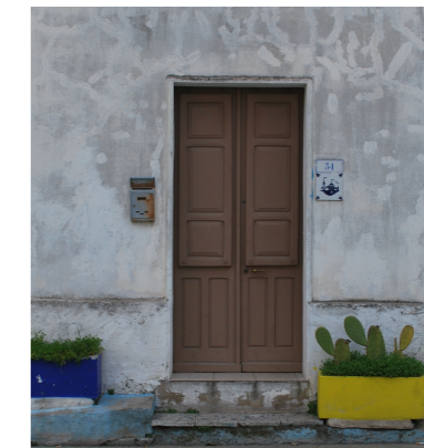
2.c | Infisso in legno a due ante con portelloni amovibili in legno
