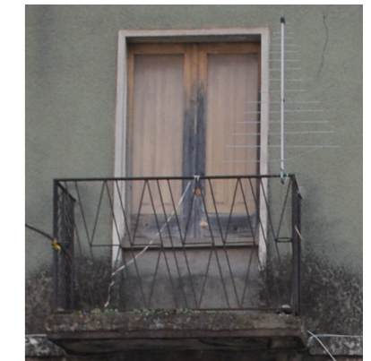
2.a.3.3 | Balcone aggettante con parapetto in ferro battuto e mensola in ferro
