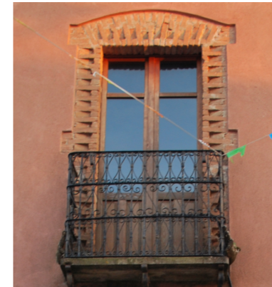
2.a.2 | Balcone aggettante con parapetto in ferro battuto
