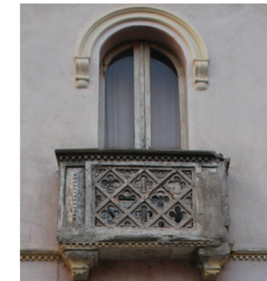
2.b.3.2 | Balcone aggettante con parapetto e mensola in cls lavorato
