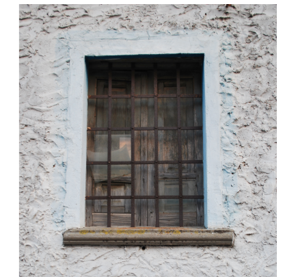
2.b.1 | Infisso in legno a due ante, con scurini interni in legno e grata metallica
