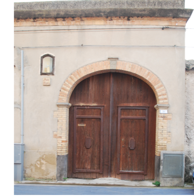
2.2.c.c.1.1 | Portale con arco a tutto sesto in conci lapidei e stipiti in conci lapidei a vista
