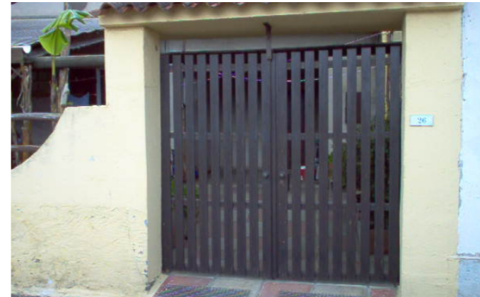
2 | Cancelli a due ante in elementi lignei verticali (s'ecca)
